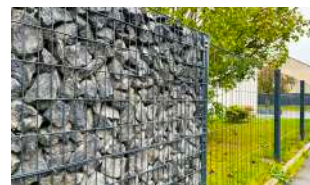
P.104 - Clôture gabion
